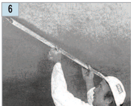
Выравнивание поверхности рейкой
