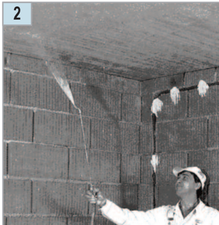
Нанесение грунтовки распылителем
