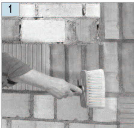
Нанесение грунтовки
