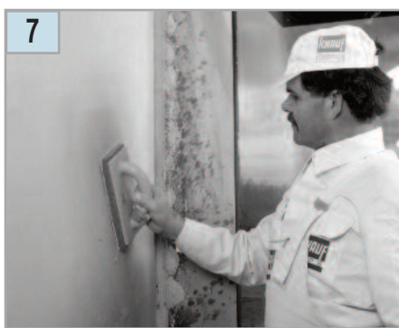
Затирка поверхности губчатой тёркой
