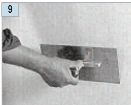
Заглаживание поверхности
