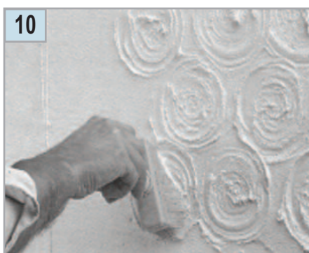
Структурирование поверхности кистью
