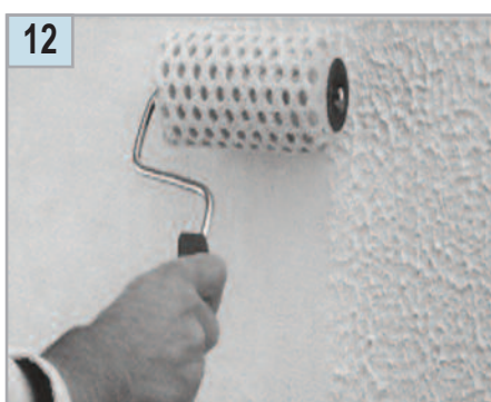
Структурирование поверхности валиком
