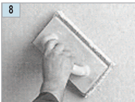
Затирка поверхности войлочной тёркой
