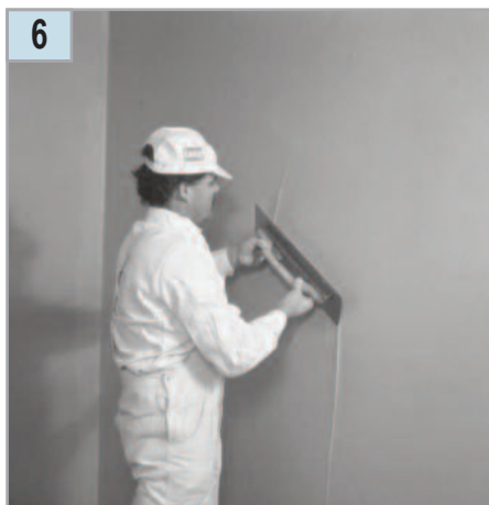
Выравнивание поверхности широким шпателем
