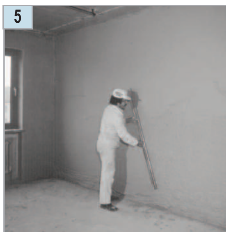
Выравнивание поверхности рейкой
