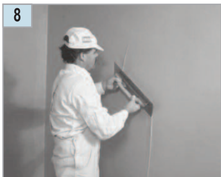
Выглаживание широким шпателем
