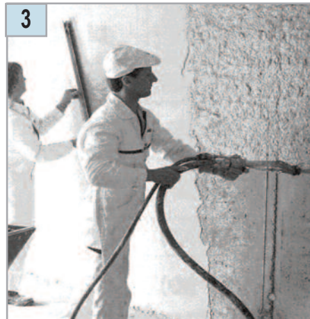
Механизированное нанесение раствора
