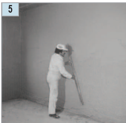
Выравнивание поверхности рейкой
